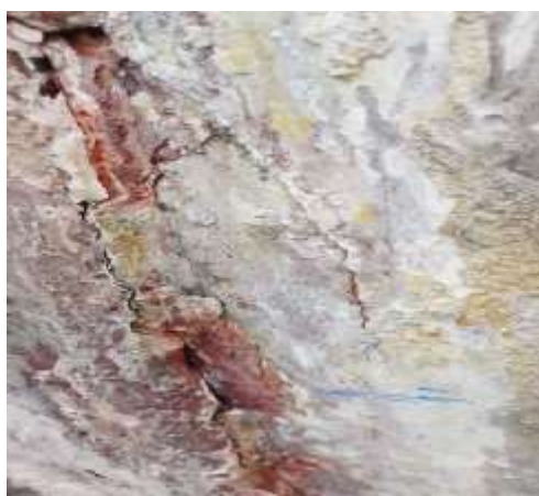
شکل ۴- ترک‌های بدنه پس از انجام آزمایش مواد نفوذ
