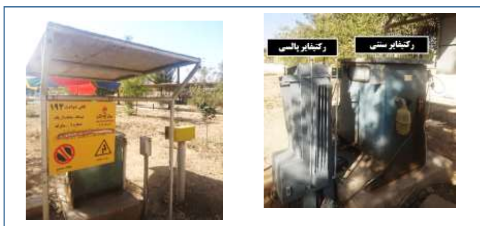
شکل ۳ - تصویر رکتیفایر سستی و پالسی در کنار یکدیگر در محل ایستگاه حفاظت کاتدی.
