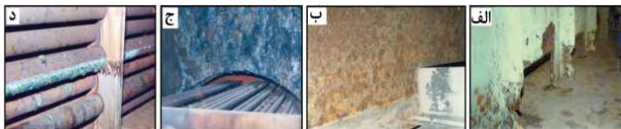
شکل ۸- خوردگی در: (الف) طبقه سوم محفظه پاشش، (ب) سقف و دیوار طبقه هشتم محفظه پاشش، (ج) خوردگی سمت بخار در تبخیر-کننده و (د) خوردگی لوله‌های انتقال حرارت [۴۲].
